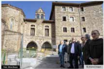
Viernes 27 octubre 2022 López Marcano, acompañado del obispo de Santander y varios alcaldes lebaniegos, comprueba el arranque de las actuaciones que mejorarán la cubierta del edificio y los baños públicos para peregrinos y visitantes
